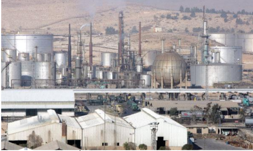
الشكل رقم (١-١): مصفاة البترول الأردنية
