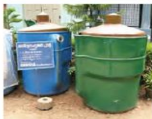
صورة 11: الهاضم الحيوي بنظام الأسطوانة العائمة الأجزاء الداخلية في الهند، مصنوعة من الألياف الزجاجية البلاستيكية المقوية (الصورة: sandec)
