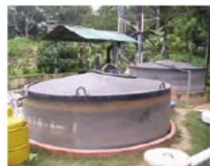
صورة 10: الهاضم الحيوي بنظام الأسطوانة العائمة في الهند (الصورة: sandec)
