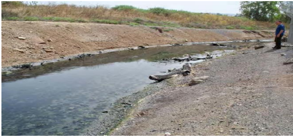
الشكل رقم (٤-٦): القناة الاصطناعية للمياه المالحة المحولة من الينابيع حول بحيرة طبريا والتي تصب في نهر الأردن المصب السفلي
